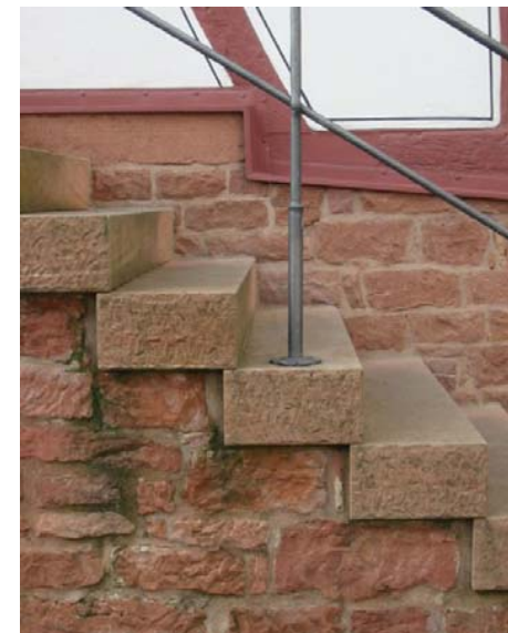
Treppenanlage in Sandstein
