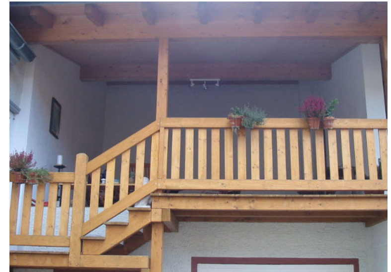
Holzloggia mit Treppenanlage
