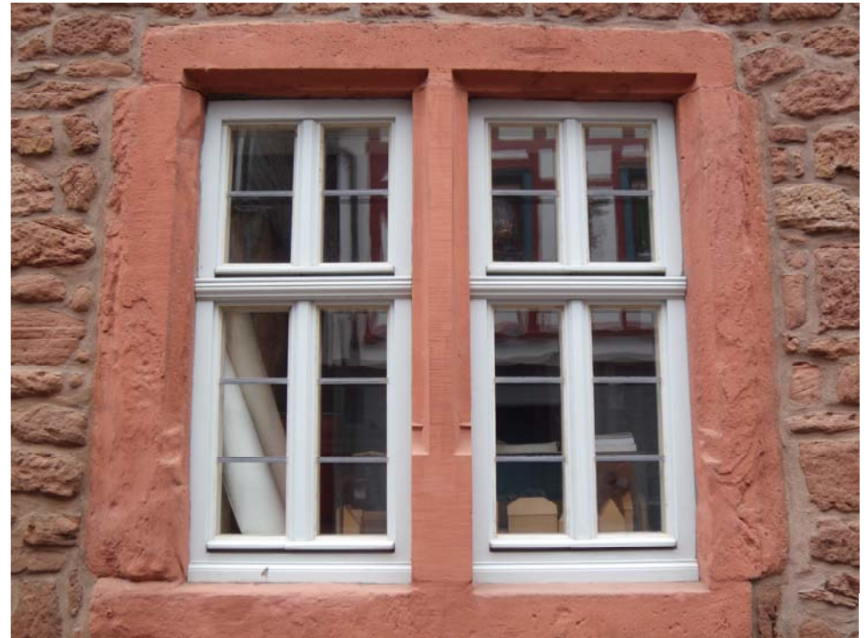
neues Holzfenster nach historischem Vorbild
