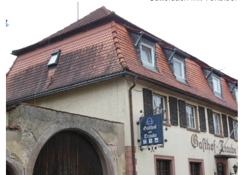
Mansarddach mit Tonbiber
