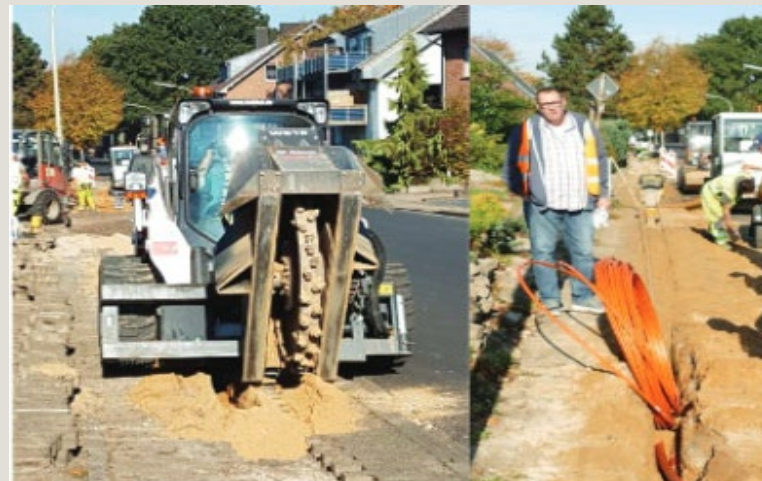
Baustellenbereich mindertiefe Grabenfräse Quelle: Deutsche Glasfaser Holding GmbH
