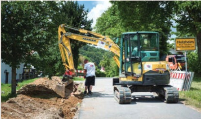
Offene Grabenbauweise (konventionell)
