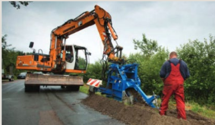
Offene Grabenbauweise Quelle: atene KOM GmbH, Florian Schuh
