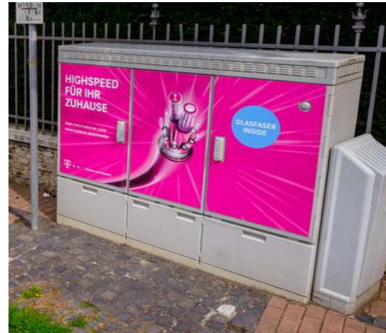
Netzverteiler (NVt)
