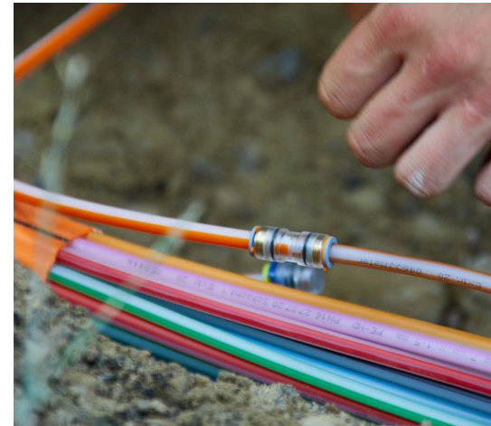
Glasfaser-Kabel zum Haus
