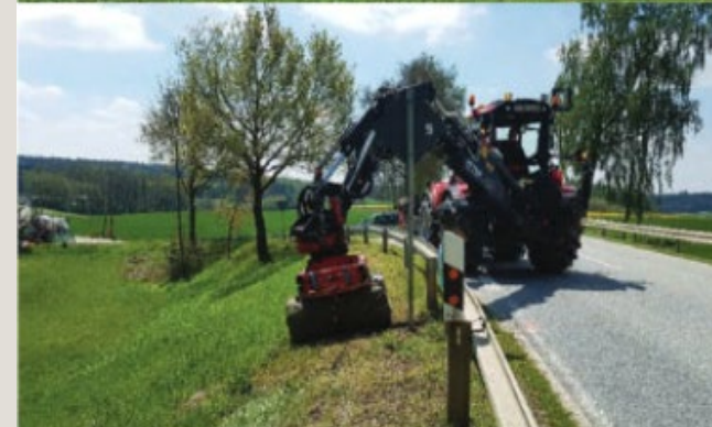
Leerrohrverdichtung im Pflugverfahren Quelle: econtech GmbH
