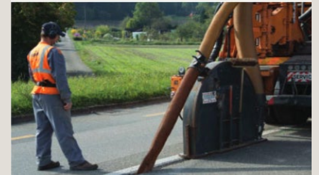
Fräsräder im Graben Quelle: Leonhard Weiss HmbH & Co. KG
