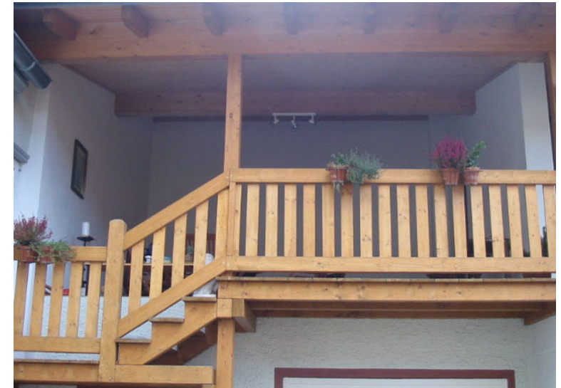
Holzloggia mit Treppenanlage
