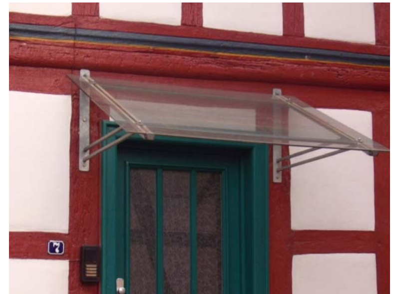
Vordach aus Stahl/Glas
