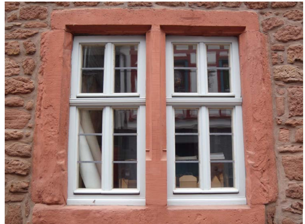
neues Holzfenster nach historischem Vorbild
